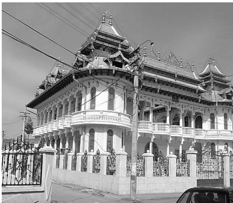
Fig. 7. “Vila Iți”, Turda – Vedere generală.
