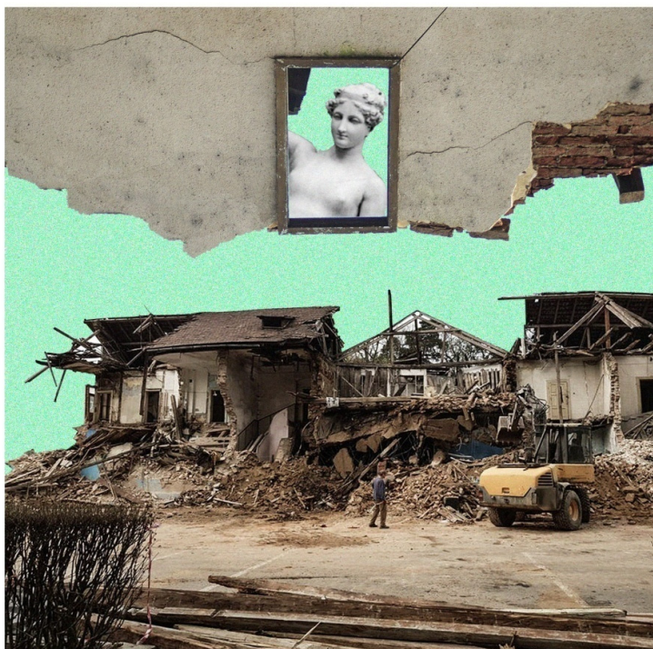
Fig. 7. Starea prezentă a moștenirii de vilegiatură românești este una incertă, pusă sub amenințare parcă atât în cazul inacțiunii, cât și în cazul acțiunii. În imagine – în partea de jos, demolarea Vechiului Hotel Hebe din Sângeorz-Băi. Sursă imagine: colaj propriu.
