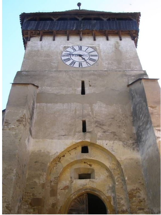
Fațada de vest a turnului bisericii
