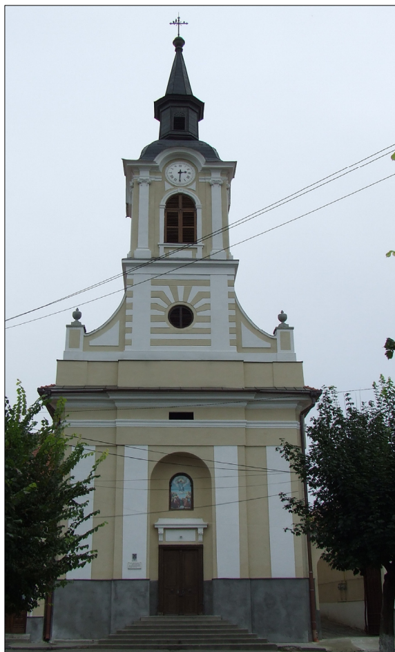
Biserica greco-catolică, Mediaș. Fațada de vest
