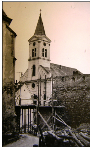
Fig. 7. Demantelarea unei porțiuni de zid pe latura de est pentru deschiderea porții (Fond DMI, dosar nr. 156)
